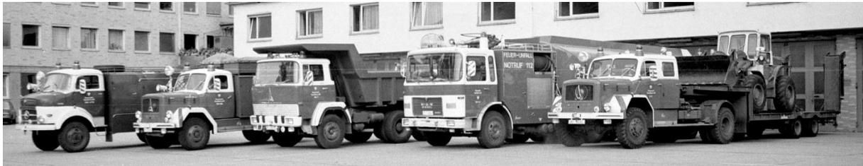
*Ölalarmzug Anfang der 1970er Jahre: Trockenlöschfahrzeug TroLF, Rüstwagen-Öl, Muldenkipper, Großtanklöschfahrzeug GTLF 24 und Tiefladesattelzug mit Caterpillar*
