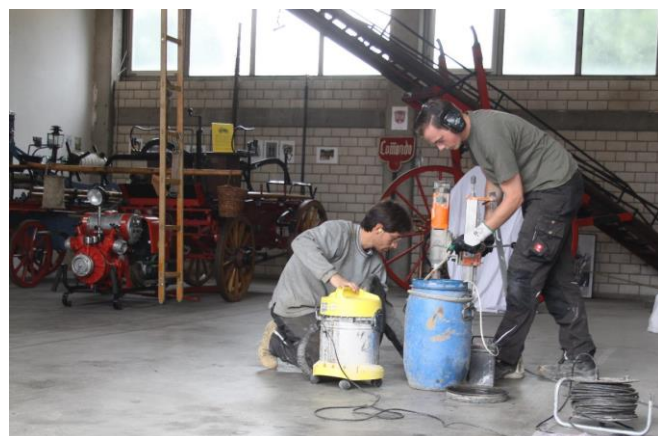
Kernbohrungen in teilweise freigeräumter Halle
