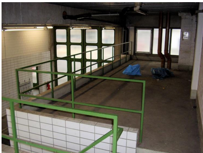
Enkheimer Halle bei Übernahme; hier Blick auf die Empore
