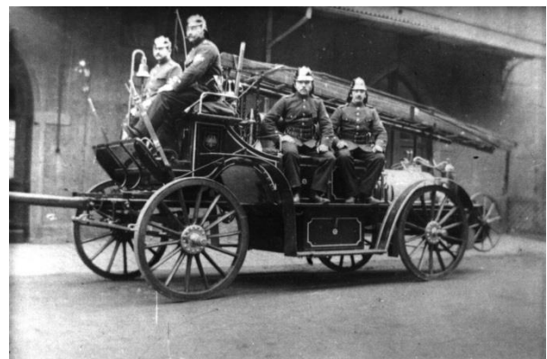
Gasspritze für Pferdezug im Hof der Feuerwache Münzgasse. Die Gasspritze hat einen 300-Liter-Wassertank, der mit Kohlensäure aus Druckgasflaschen unter Druck gesetzt werden kann und fährt als „Vorauslöschfahrzeug“ der Dampfspritze voraus.
